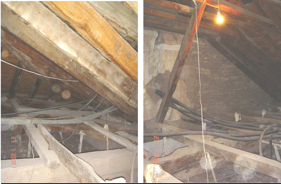
Bajocubiertas estado inicial
