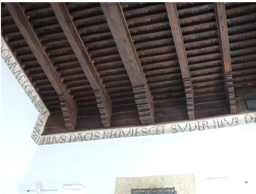
Alfarje rehabilitado y falsa viga eliminada
