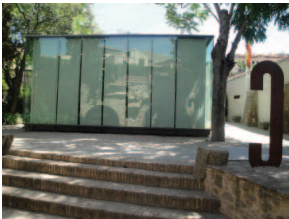
4. El cubo acristalado situado en el segundo jardín y en el muro de cierre donde se han instalado la taquilla y otros servicios.
