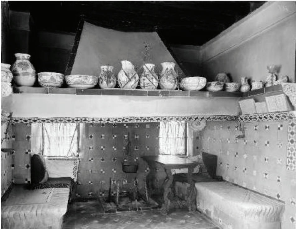
11. Cocina antigua . Vista actual.
